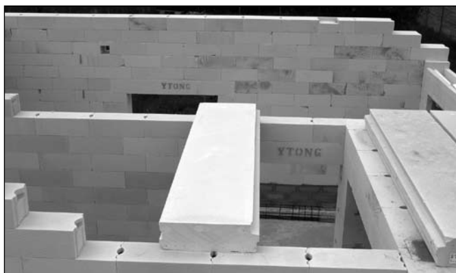
Zdjęcie 6. Płyta stropowa ułożona na ścianach nośnych.
