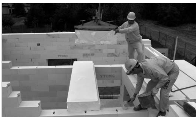
Zdjęcie 7 i 8. Nanoszenie warstwy zaprawy do cienkich spoin YTONG pod kolejną płytę.
