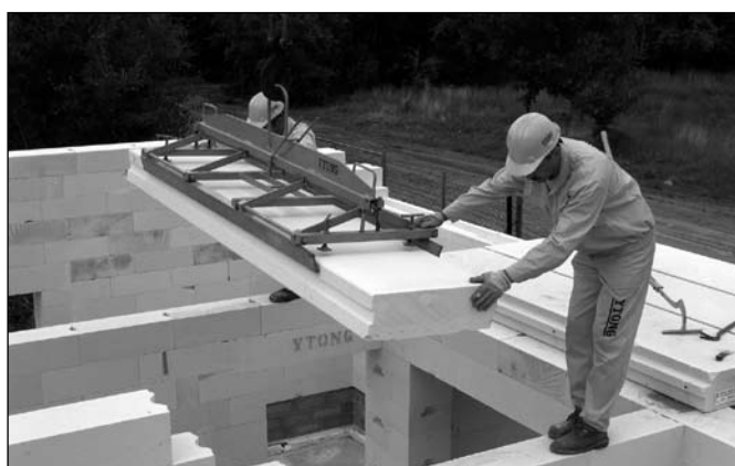
Zdjęcie 4 i 5. Układanie płyty stropowej YTONG.
