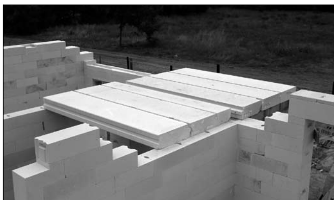
Zdjęcie 11. Strop z płyt stropowych YTONG ułożony na ścianach nośnych.
