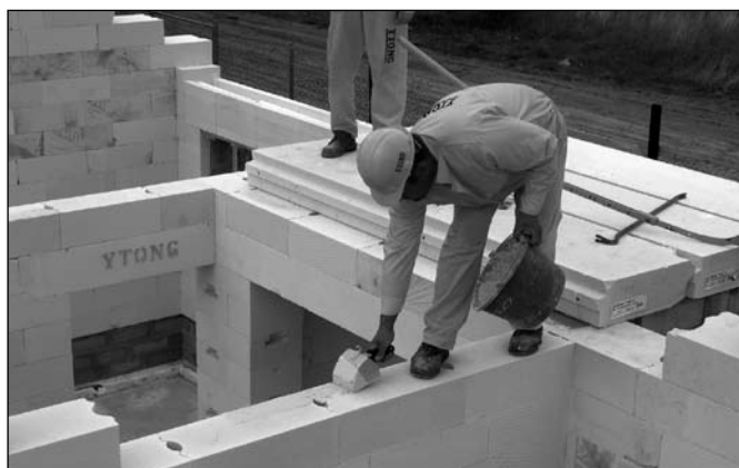
Zdjęcie 3. Nanoszenie na ściany nośne warstwy zaprawy do cienkich spoin YTONG.
