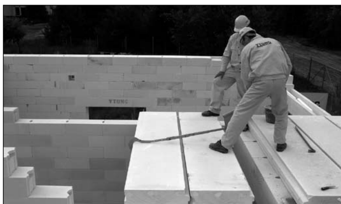
Zdjęcie 9 i 10. Ścisłe dosuwanie do siebie płyt stropowych YTONG za pomocą ściągu montażowego.
