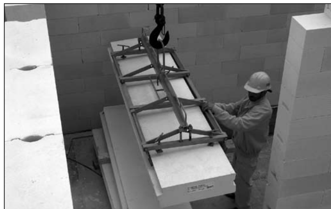
Zdjęcie 2. Transport płyty stropowej YTONG na miejsce montażu.
