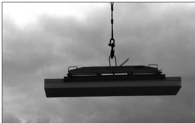
Zdjęcie 1. Zawiesie do transportu i montażu płyt stropowych i dachowych YTONG.
