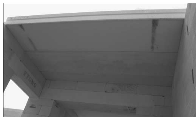
Zdjęcie 12. Widok powierzchni sufitowej stropu z płyt stropowych YTONG.
